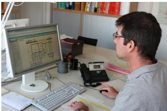
Foto 6: Optimierung und Überwachung an der MBE 4 Stuttgart
